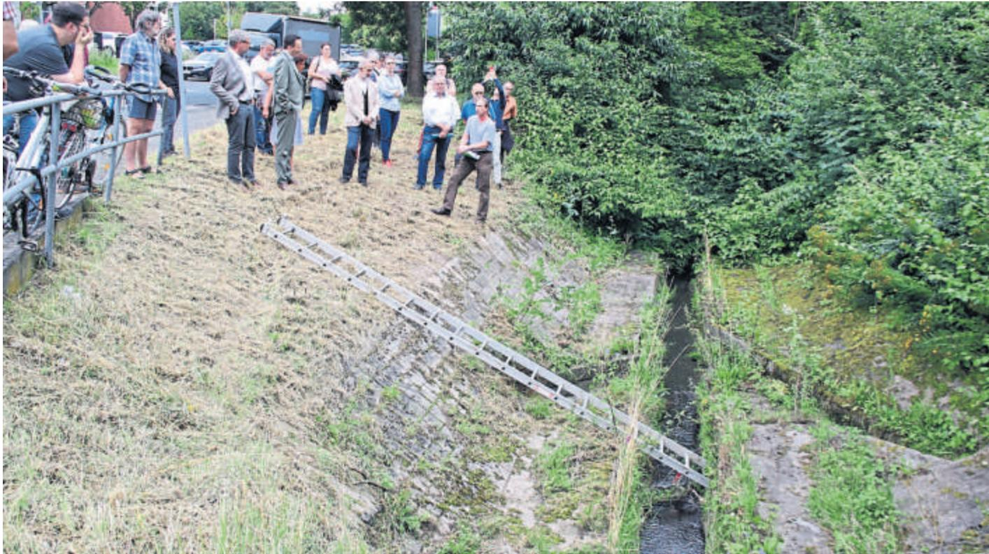
Der kerzengerade Kanal rechts im Bild ist die Straßbach in Höhe der Mitsubishi-Zentrale im Industriegebiet Süd. Das Bachbett besteht nicht aus Kies, sondern aus Beton.
